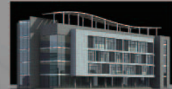
江苏省工业废酸资源回收 利用工程技术研究中心 Jiangsu Industrial Wasteacid Recycling Engineering Research Center
