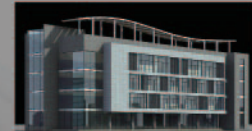
江苏省工业废酸资源回收 利用工程技术研究中心 Jiangsu Industrial Wasteacid Recycling Engineering Research Center
